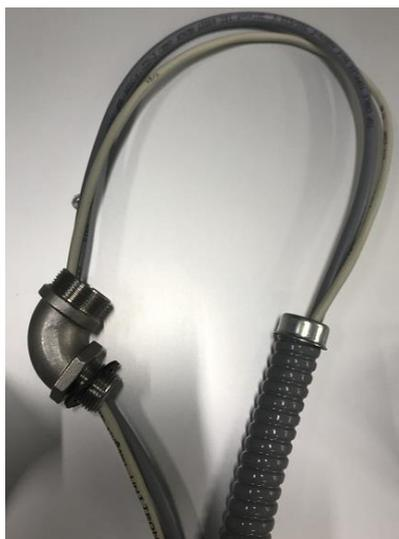
Engager les câbles à travers le raccord coudé avant de le monter sur le mât (laisser 50cm de mou)
