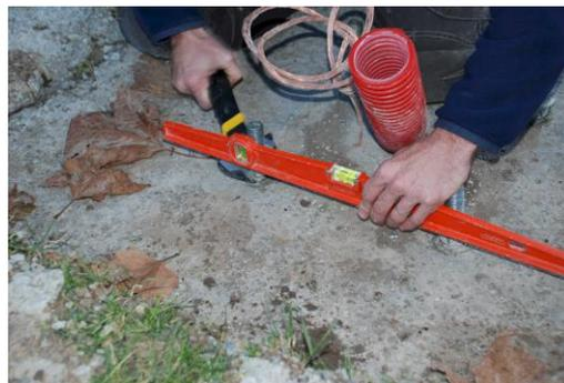
Pré-réglage du niveau avec les contre-écrous
