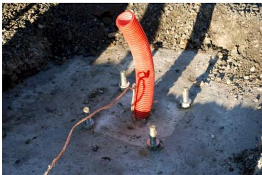
Tiges de scellement après dépose du gabarit
