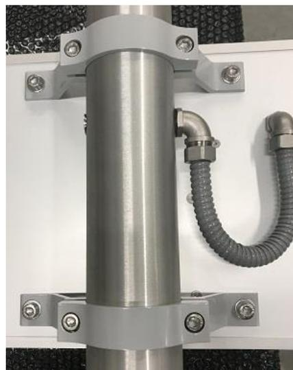
Raccord coudé en place et caisson fixé à la bonne hauteur
